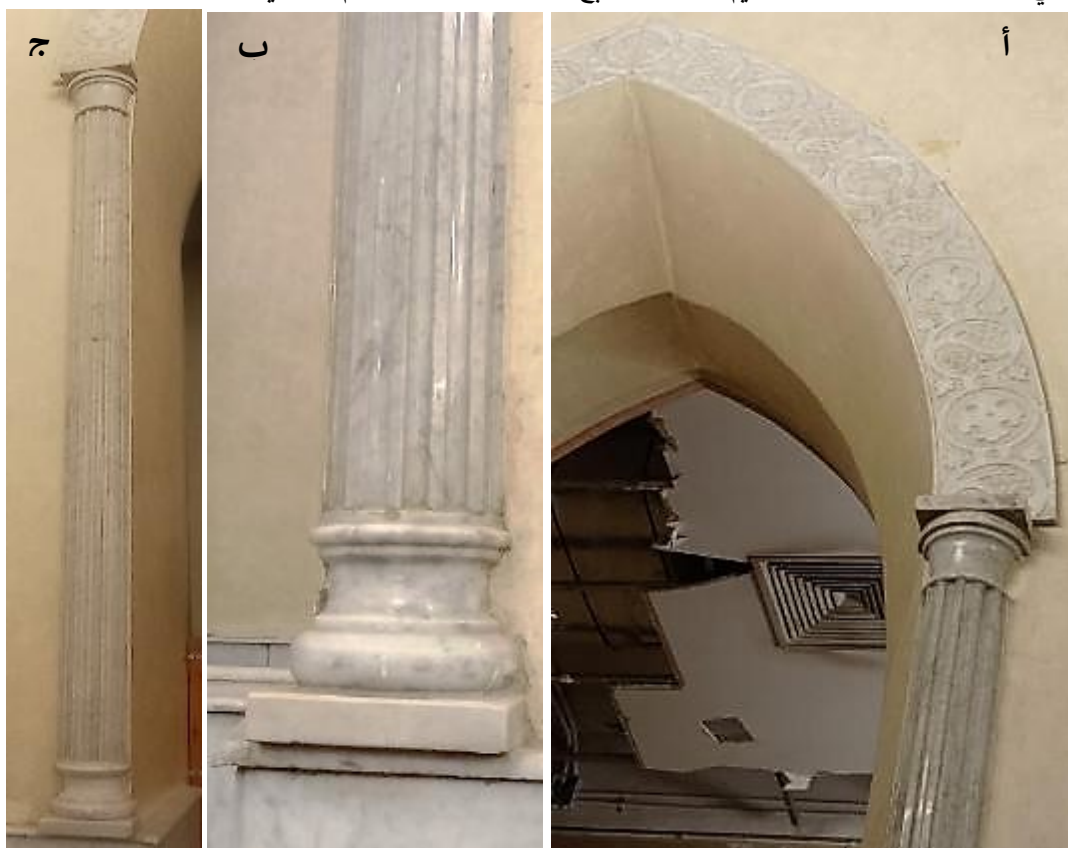
لوحة 23 أ. جزء تفصيلي من إحدى النوافذ بالقسم الشرقي ويظهر بها الإطار الرخامي وزخارفه وأنصاف الأعمدة الرخامية بتاجها الناقوسي التي تزين جانبي النافذة ب. البدن ذات الخشخانات مع القاعدة الناقوسية لأنصاف الأعمدة التي تزين جانبي النوافذ ج. منظر عام لأنصاف الأعمدة التي تزين جانبي النوافذ بالقسم الشرقي بكنيسة السيدة العذراء مريم بالأقصر وترجع للربع الأخير من القرن 19 م تصوير الباحث © تنشر لأول مرة.
