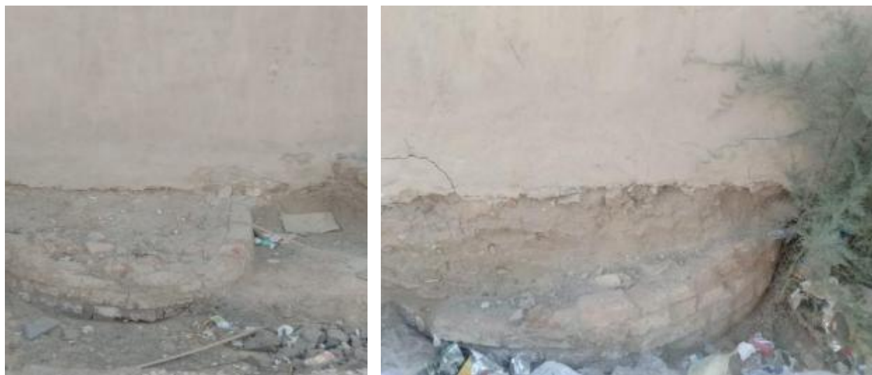
لوحة ٢ صورة للآثار القديمة التي بنيت عليها كنيسة السيدة العذراء مريم بالأقصر ويظهر بها مجموعة من مداميك الطوب الأجر المثلثة بالطين بتصوير الباحث © تنشر لأول مرة
