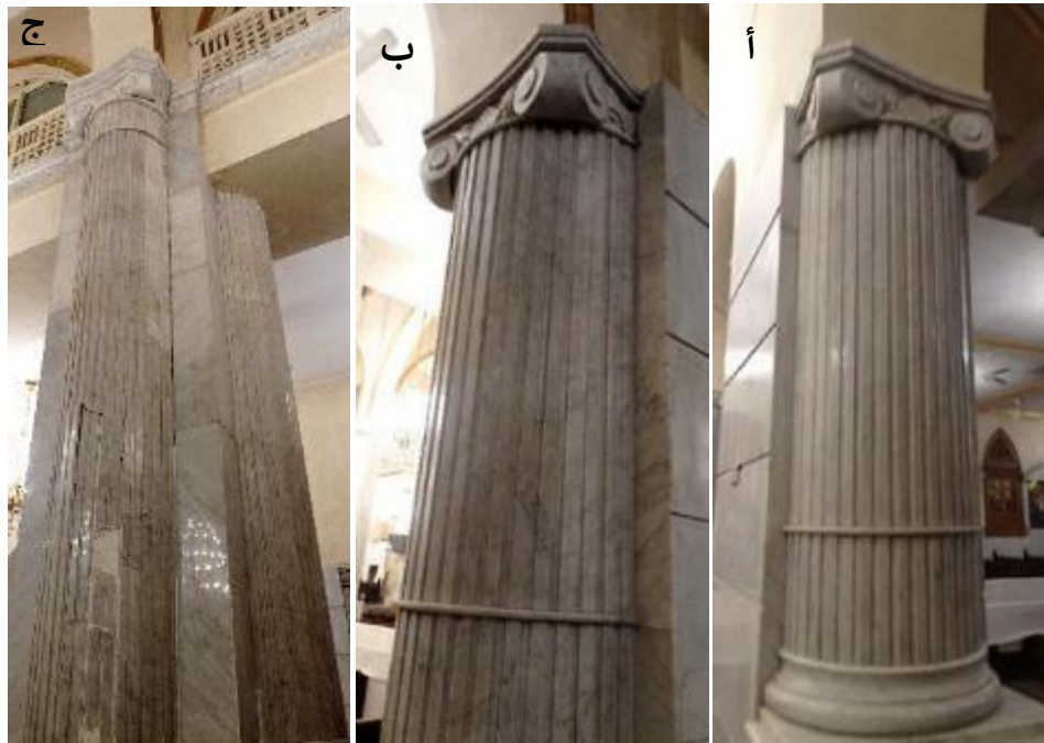
لوحة ١٣ أ، ب. أنصاف الأعمدة الرخامية الأيونية الطراز المثبتة بجوانب الدعامات الغربية الحاملة لسقف الممر الغربي المستعرض ب. الدعامات الصليبية الحاملة لسقف الممر الغربي من الجهة الشرقية، ويفصل الممر الغربي بين القسم الشرقي والغربي بكنيسة السيدة العذراء مريم بالأقصر والتي ترجع للربع الأخير من القرن ١٩م. تصوير الباحث © تنشر لأول مرة.
