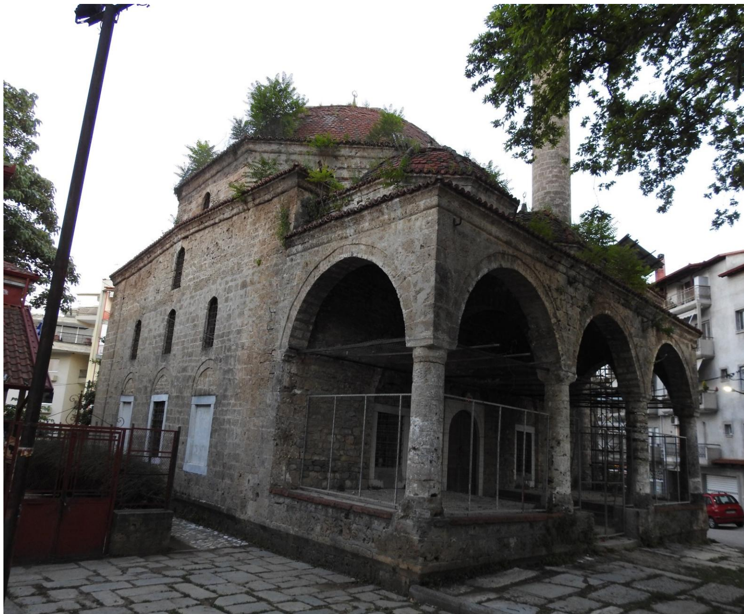
Εικόνα 4. Η βορειοανατολική πρόσοψη του Γενί Τζαμιού (Φωτογραφία από την ερευνήτρια)
