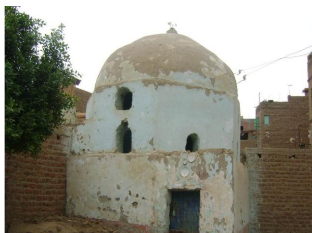
لوحة (11) قبة الشيخ رمح بقرية شندويل البلد مركز المراغة، القبة من الخارج (تصوير الباحثة)
