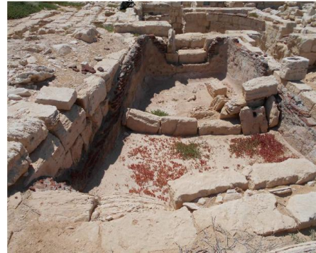
صورة لأجزاء من الحجرات في حمام مارينا العلمين اليوناني ويظهر بها اختلافات سمك الجدران وبعض العيوب الإنشائي
