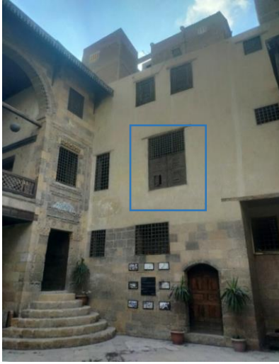
لوحة (٢) الواجهة الغربية لبيت السناري من حوش المنزل، شباك التنهة المطل على الحوش، تصوير الباحثة
