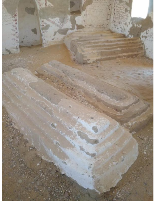
لوحة ( ١٢ ) تبين تراكيب ضريحية عبارة مصاطب متدرجة مبنية بالطوب اللبن داخل القبة الضريحية للشيخ عمران القرشي ؛ تصوير الباحثة.
