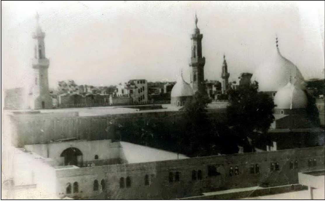
(لوحة ٢) جامع وقبة السيد الدسوقي من الواجهة الشمالية الشرقية من عهد الأسرة العلوية وقبل توسعته سنة ١٣٨٨هـ/١٩٦٩م، عن: مسجد سيدي إبراهيم الدسوقي، عن:
