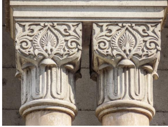
لوحة (١٠) : تيجان أعمدة البائكة التي تتقدم المدخل الرئيسي لجامع صلاح الدين الأيوبي بالمنيل .
